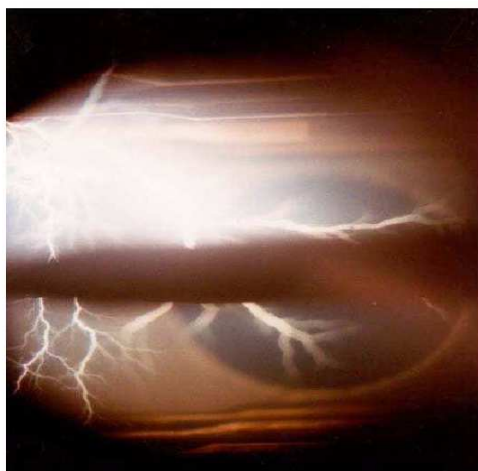
Zdj. 2. Wyładowania iskrowe wewnątrz filtra mechanicznego.
